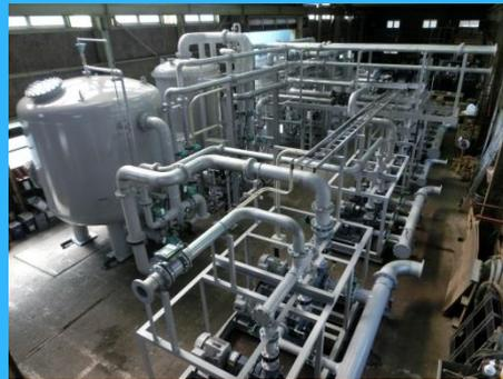
高濁度原水対応型浄水装置
