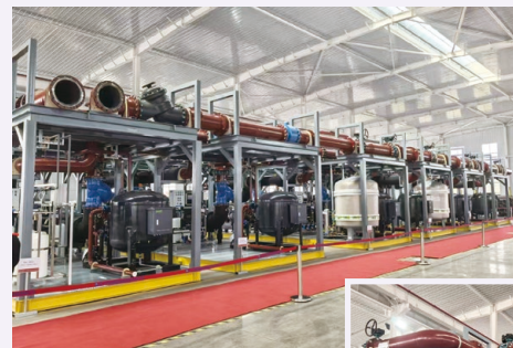
プレハブユニット施工例
