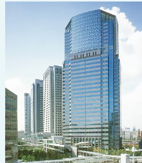
品川イーストワンタワー（大東建託本社ビル）
