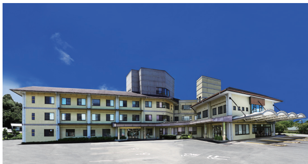
介護老人保健施設リバーサイド御薬園 (熊本市)
