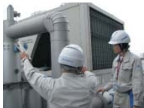
屋上で機器や配管等を見ながらの指導。
