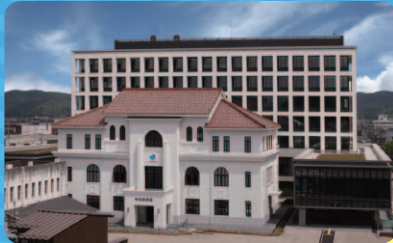
豊岡市庁舎(兵庫県豊岡市)
