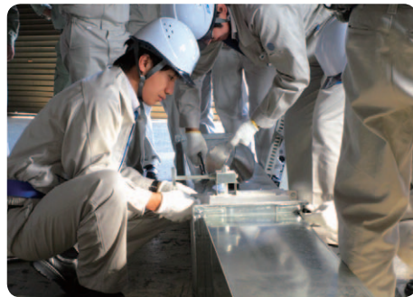
ダクト吊込み体験
