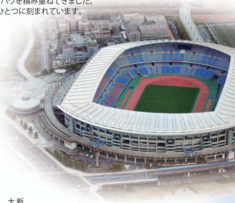
横浜国際総合競技場(日産スタジアム)
