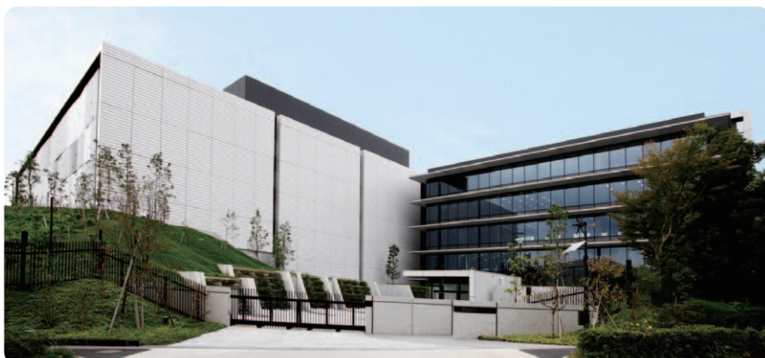
野村総合研究所 東京第一データセンター(東京都)
