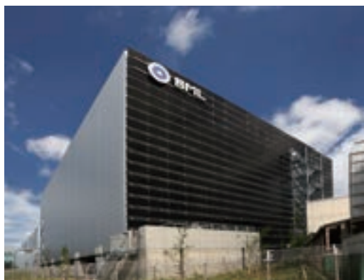
BML総合研究所新棟建設計画A棟 (6期棟) (埼玉県)
