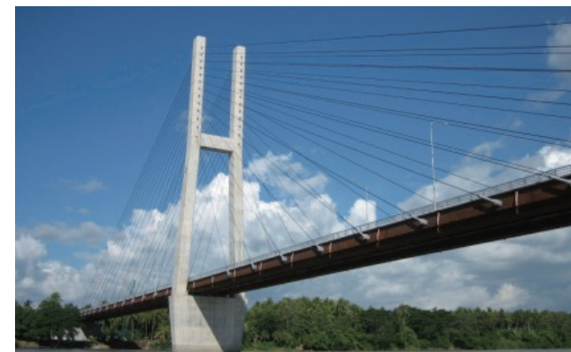
フィリピン 第二マグサイサイ橋・バイパス道路建設事業
