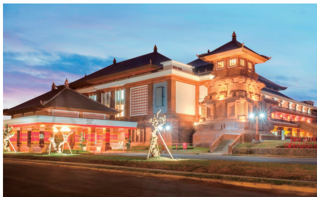
インドネシア共和国 パリ文化ホール新築工事
