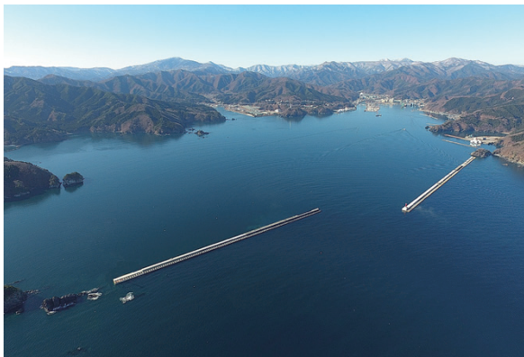
岩手県釜石市 釜石湾湾口地区湾口防波堤(災害復旧)(北堤)築造工事
