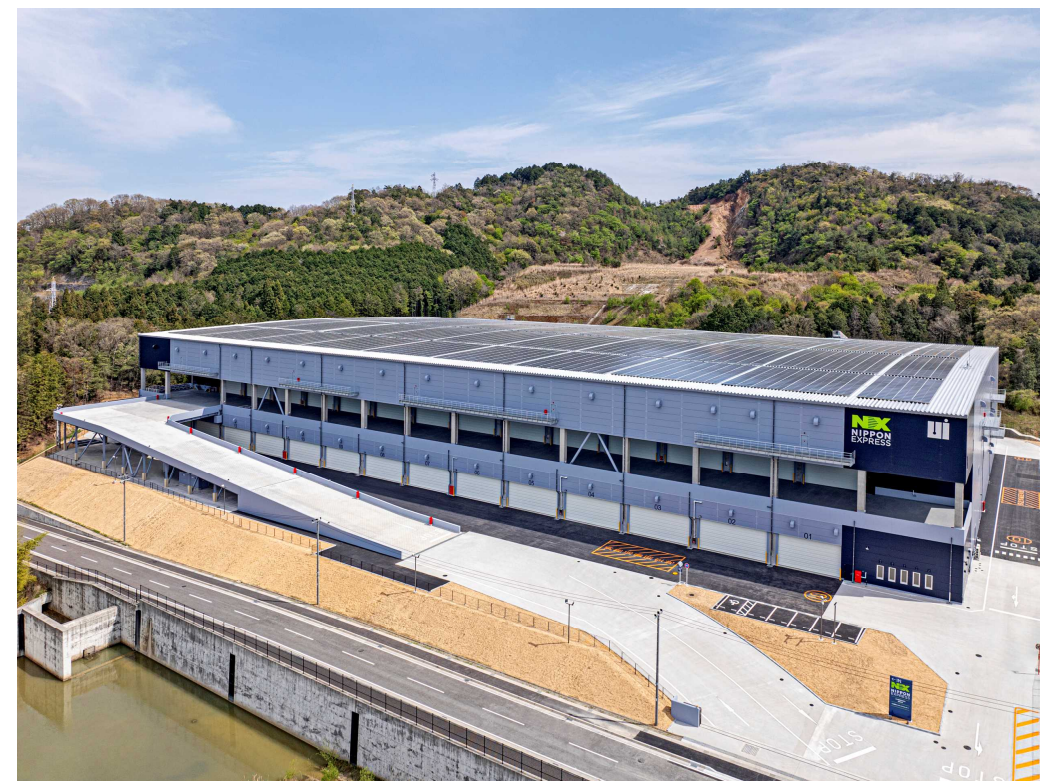
(仮称) UI湖南ロジスティクスセンター第Ⅰ期計画新築工事
