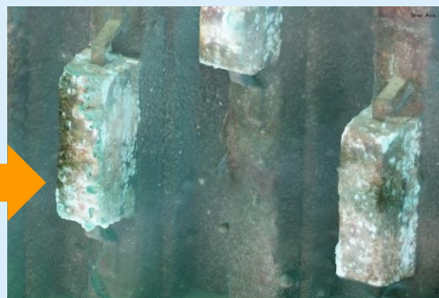
鋼矢板護岸前面の 水中3D画像 (電極設置部分)
