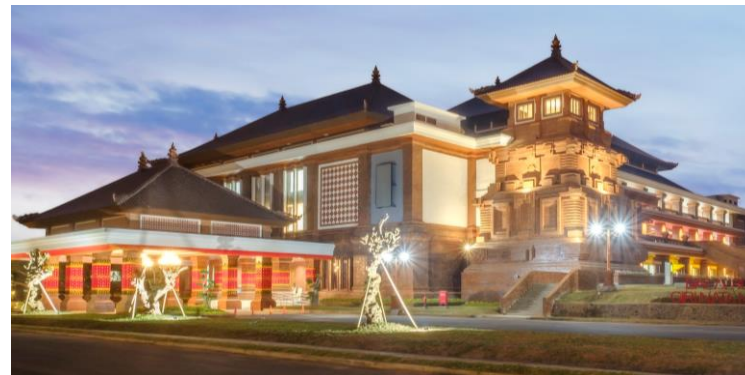
バリ芸術劇場建設工事
