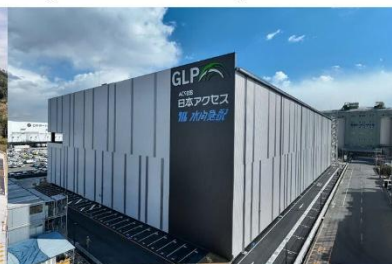
GLP Kobe Sumiyoshihama
