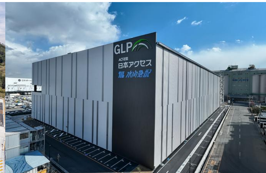
GLP Kobe Sumiyoshihama
