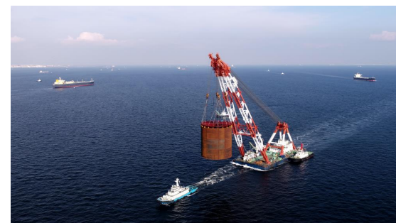
鋼板セルは、 富津市から新本牧まで吊運搬
