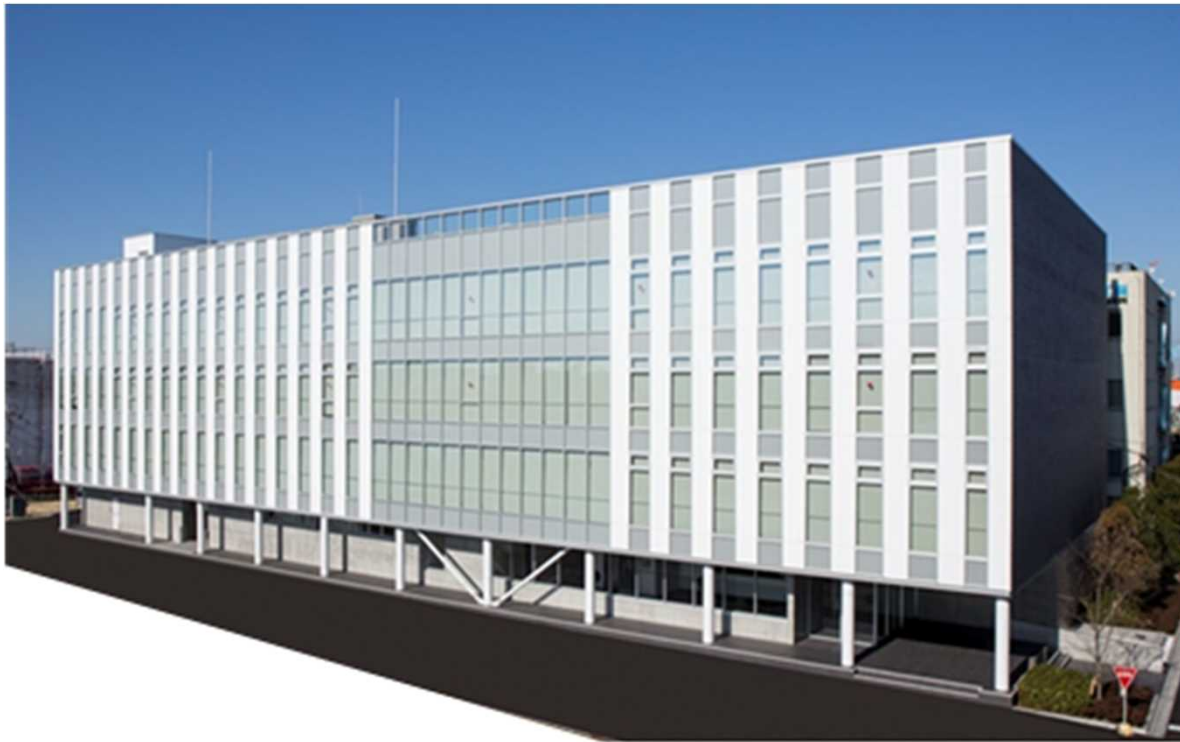
技術研究開発センター研究棟
