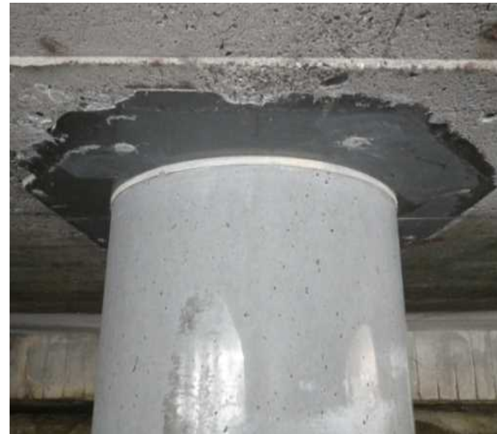
接合部の補強状況
