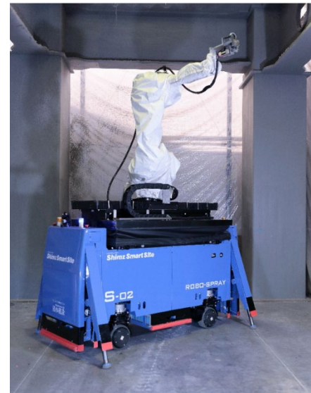
アウトリガーを張り出したRobo-SprayII
