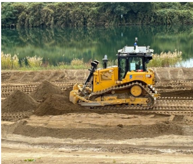
実証施工（土砂山の敷き均し）
