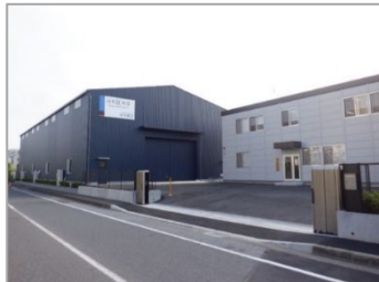
清水匠技塾の外観
