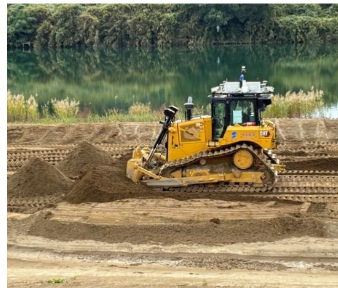
実証施工 (土砂山の敷き均し)
