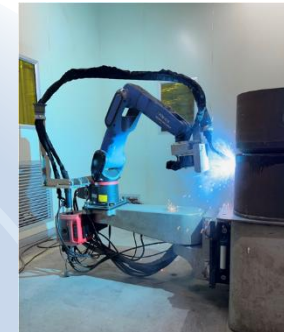
溶接ロボット Robo-Welder
