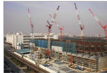
コンクリートリサイクル
