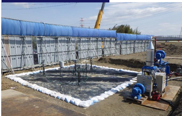
三重県桑名市源十郎 熱脱着土壌浄化（試験施工）
