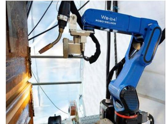
鉄骨柱の溶接作業中の「Robo-Welder」
