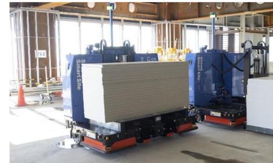
資材の搬送効率を向上させる「Robo-Carrier」
