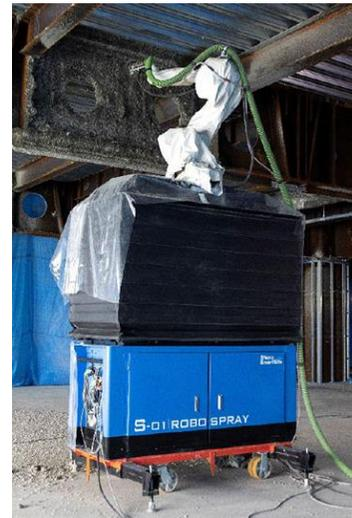
半乾式耐火覆吹付ロボット「Robo-Spray」
