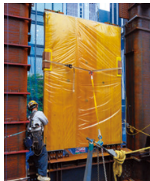
工場で製作したハイウッドウォールを現場に取り付け
