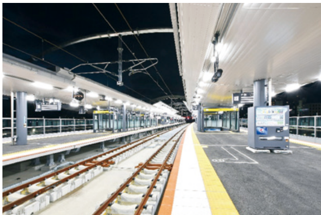
南方から3番線ホームを望む
