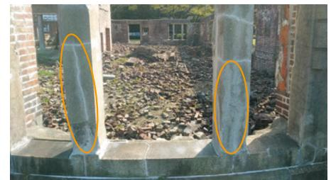
写真左側が1989年の樹脂注入によるひび割れの補修
