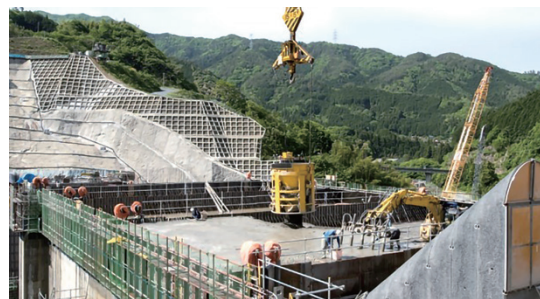
堤体コンクリート打設の様子。軽量バケット（写真中央の黄色の容器）の開発で打設能力を10%アップした
