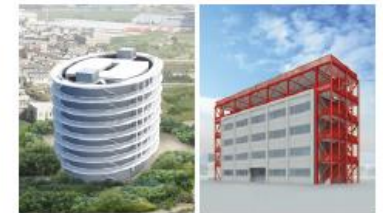
津波対策 (津波避難ビル)
