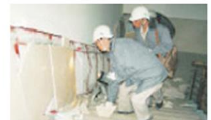
被災度判定 (構造物、設備、外装、内装)
