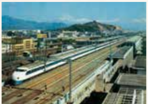
1964 東海道新幹線静岡駅高架橋 日本の東西をつなぐ 国家的プロジェクトに参画
