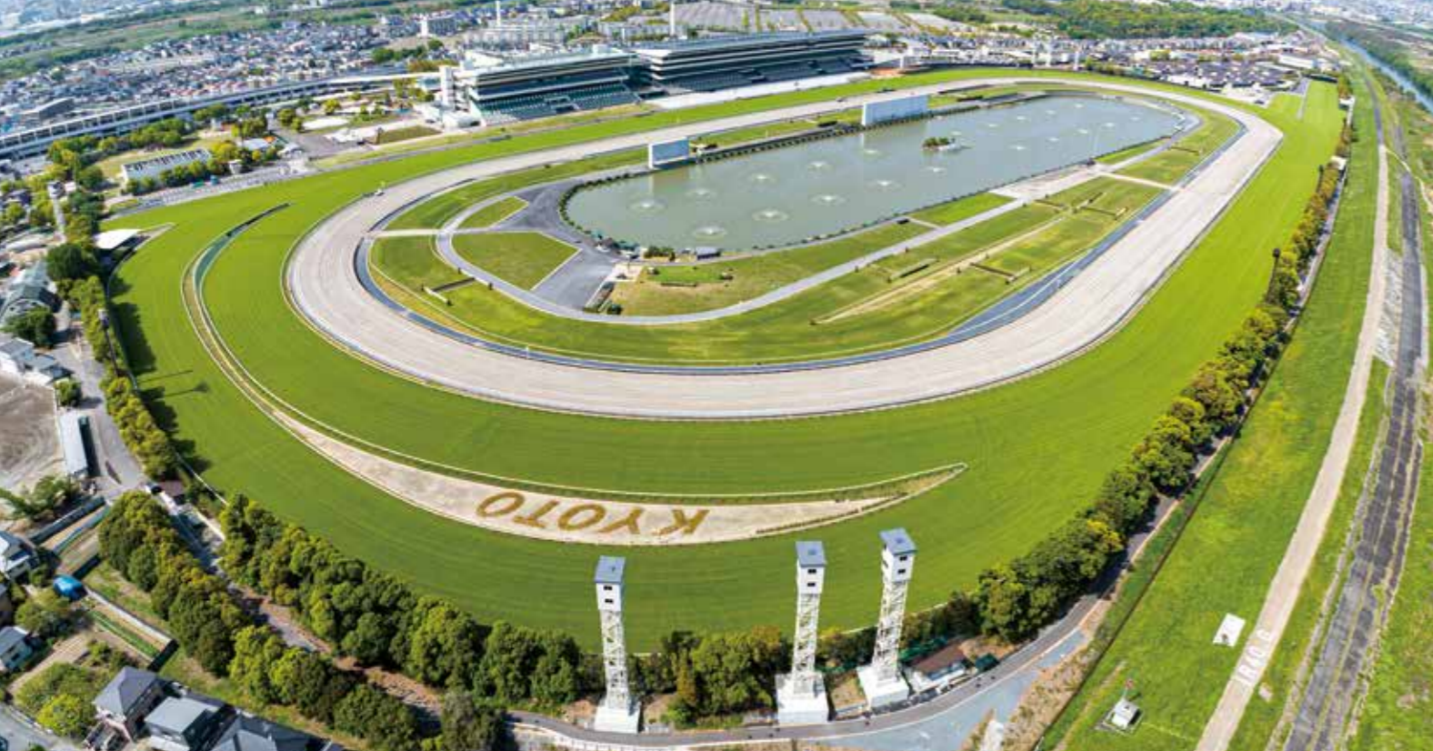
京都競馬場整備工事(馬場工区)(京都市伏見区) 日本道路とのJVで馬場工区を施工
