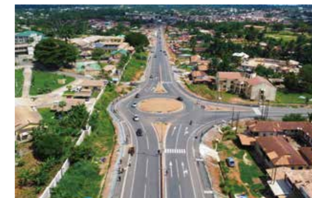
ガーナ第2の都市であるクマシを沿岸部につなぐ国道改修工事
