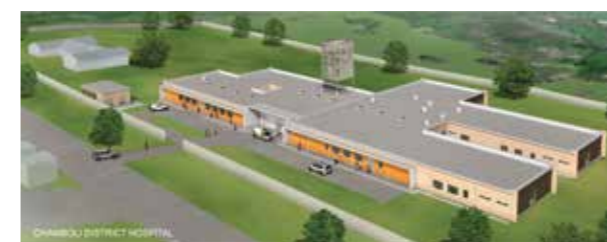
コッパルバート州における保健センターの郡病院への改善計画(ザンビア)
