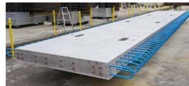
完成したPC道路橋床版
