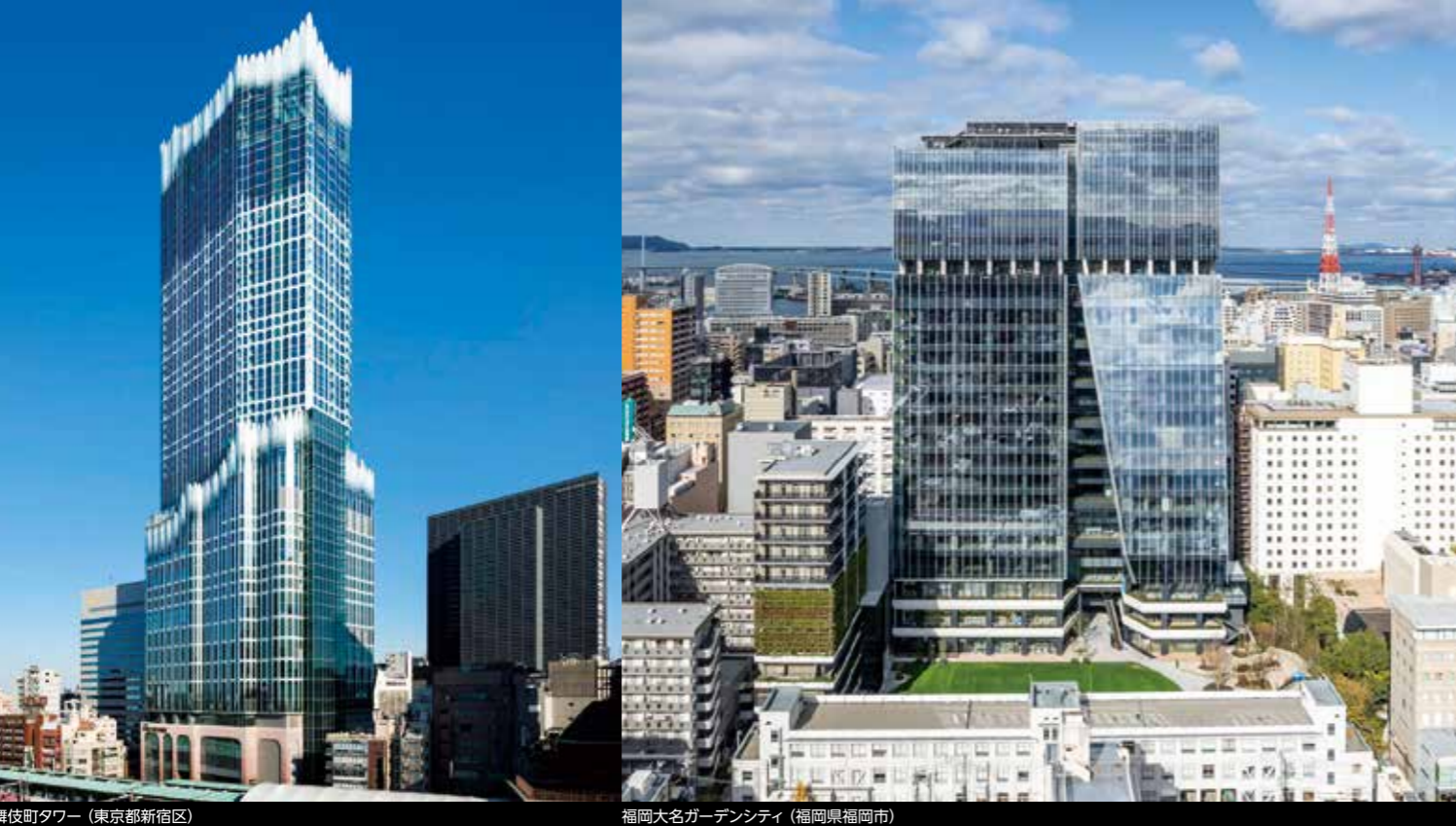
東急歌舞伎町タワー(東京都新宿区)
