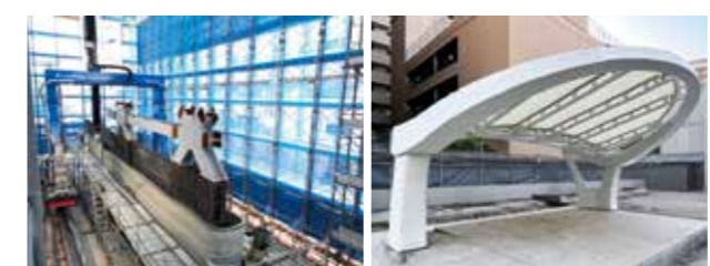
オンサイト3Dプリンティングの施工状況 プリント構造体を適用した駐車場屋根構造物
