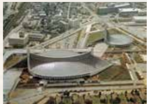
1964 国立屋内総合競技場主体育館 世界に類を見ないケーブルによる吊り屋根構造
