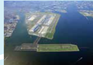
2010 東京国際空港D滑走路 世界でも珍しい埋立と橋脚のハイ ブリッド構造を採用した大規模海 上滑走路 (画像提供:羽田再拡張D滑走路JV)
