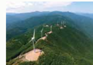
2022 ユーラス上勝神山ウインドファーム 2.3MWの風力発電機15基を 設置
