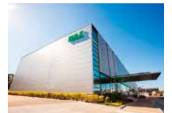
本社機材センター(千葉県船橋市)
