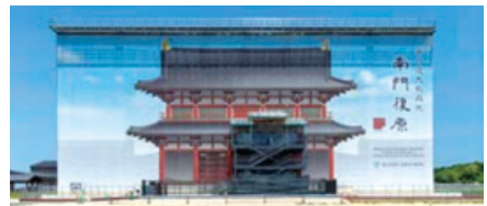
施工中は、南門を風雨から守る鉄骨造の素屋根を設置(手前の階段のある部分が見学デッキ)
