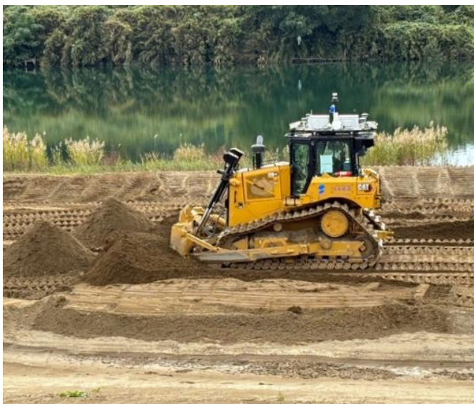
実証施工（土砂山の敷き均し）
