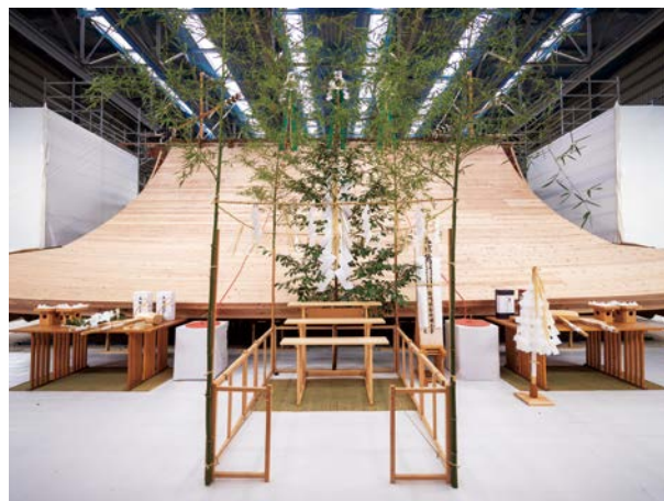
【素屋根】の中で行われた上棟祭。保存修理工事は最終段階に入り、2023年12月に竣工予定。
