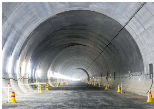
本年6月に竣工した「音中トンネル」(延長4,686m)
