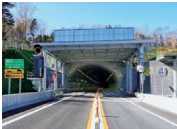
北海道横断自動車道 穂別トンネル工事 (北海道)
