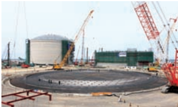
上越火力発電所に建設中のPC地上タンク3基。 基礎版鉄筋組立中のNo.3タンク（写真手前）、屋根上げが完了したNo.1タンク（左奥）、防液堤コンクリート打設中のNo.2タンク（右奥）
