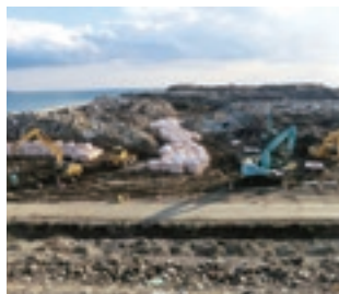
石巻ブロックの作業状況
