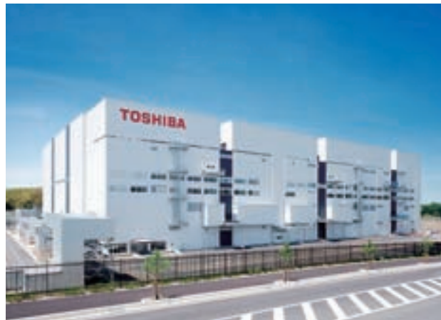
東芝四日市市場第5製造棟 (三重県) 発注者 ■ 株式会社東芝
