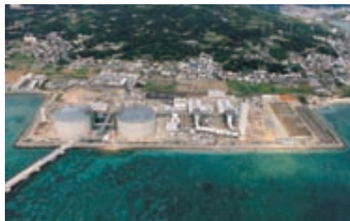
吉の浦火力発電所のPC地上タンク2基
