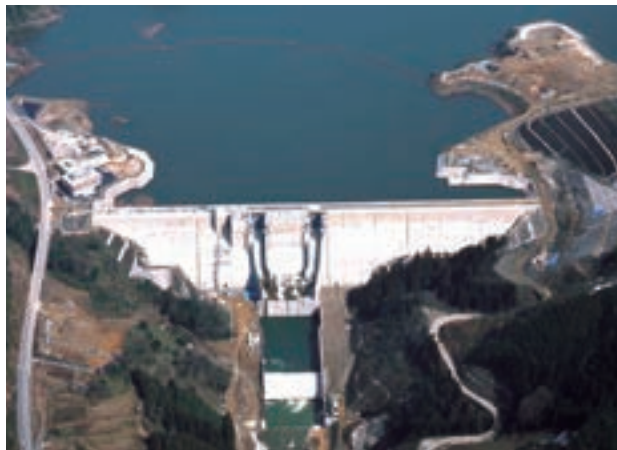
尾原ダム建設工事 (島根県)
