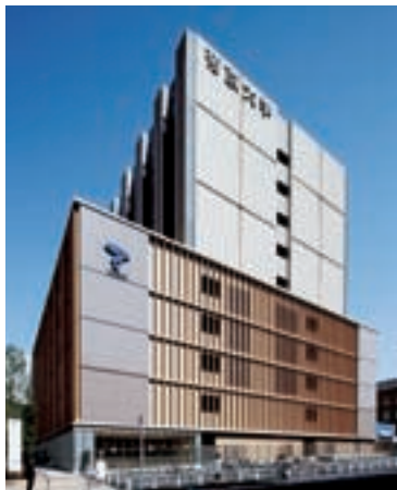
帝京大学板橋キャンパス大学棟本館 (東京都) 発注者 ■ 学校法人帝京大学
