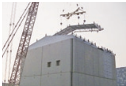
大型クレーンを使った原子炉建屋カバー工事の様子
