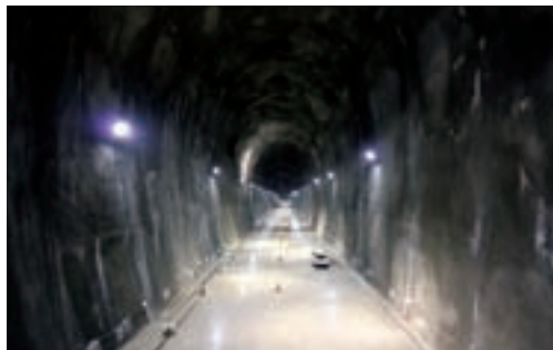
水島コンビナート地下のLPG貯蔵用トンネル
