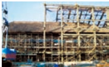
素屋根建設の様子。素屋根の側面に壁を設けず、工事中も正倉が自然の空気に触れる状態とした
