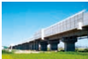
③富山野々上高架橋 ラーメン高架橋, 桁式高架橋を施工
