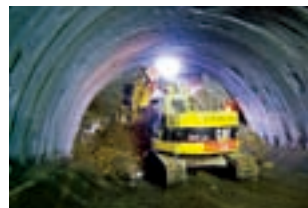
④第2魚津トンネル 施工延長3,097m。富山～黒部宇奈月温泉間で最長のトンネル
