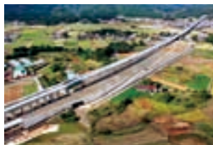
⑦上越上中田高架橋 ラーメン高架橋, 桁式高架橋及び保守基地盛土を施工
