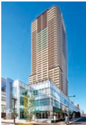
セントア武蔵小杉・ プラウドタワー武蔵小杉・ ケイジェイレジデンス 武蔵小杉 (神奈川県)
