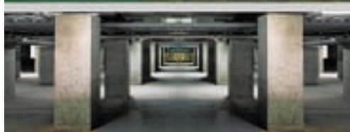
生産ラインエリアの二重床。PC床版の下に深さ3mのピット（空間）が設けられ、設備や配管類が設置されている
