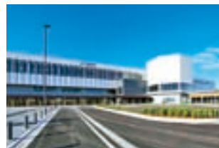
⑧上越妙高駅新築, 同駅高架橋 高架部から新駅建設に至る一連の工事を施工
