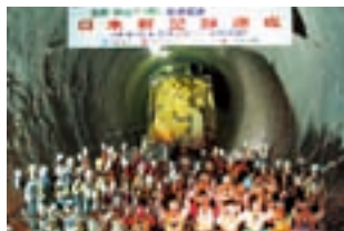
⑥峰山トンネル (西工区) 施工延長3,790m。国内最大級の掘削機により当時の最高月進記録を大幅に更新
