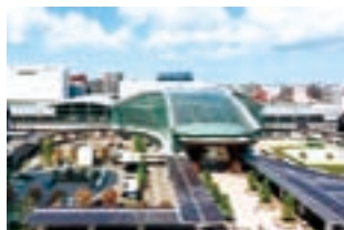
①金沢駅新築, 同駅ホーム桁 金沢の玄関口となる新駅, 駅ホーム桁, 東口広場 (もてなしドーム) を施工
