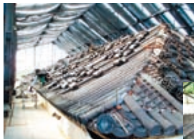
瓦工事の様子
