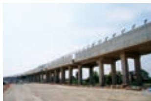
②射水土合高架橋 ラーメン高架橋, 桁式高架橋を施工
