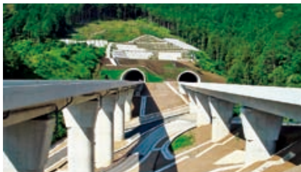
第二東名高速道路 東上トンネル他1トンネル工事(愛知県)
