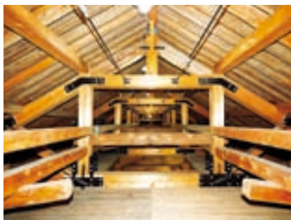
小屋組の補強
