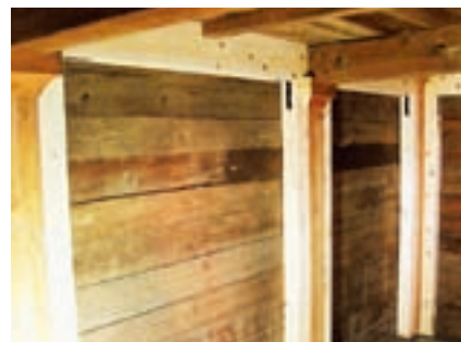
梁と柱の補強(色の薄い檜材が今回新設箇所)
