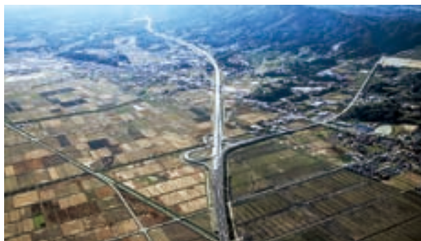
常磐自動車道山元工事(宮城県)
