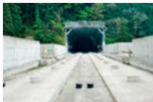
⑤朝日トンネル (東工区) 施工延長4,155m。地山の変位を抑制する工法を採用して施工
