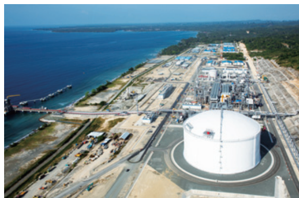
Donggi Senoro LNG Tank, Indonesia
