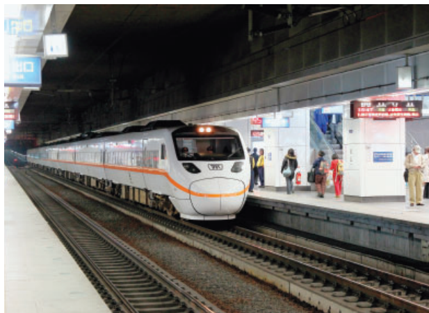
台湾鉄道松山駅地下化工事 (台湾) 設計 ■ 中興工程顧問股份有限公司
