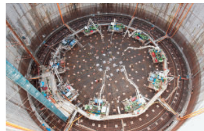
2011年2月、4昼夜連続で行われた底版コンクリート打設工事の様子（地上からタンク内を見下ろす）
