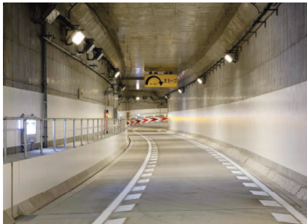
神戸山手線連絡路(北行)開削トンネル工事 (神戸市) 設計 ■ 阪神高速道路(株)
