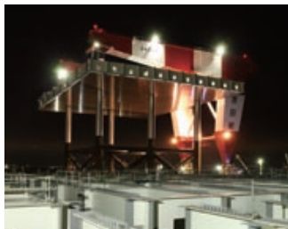
ジャケットの据え付け作業の様子。 月に4基のペースで作業を行った
