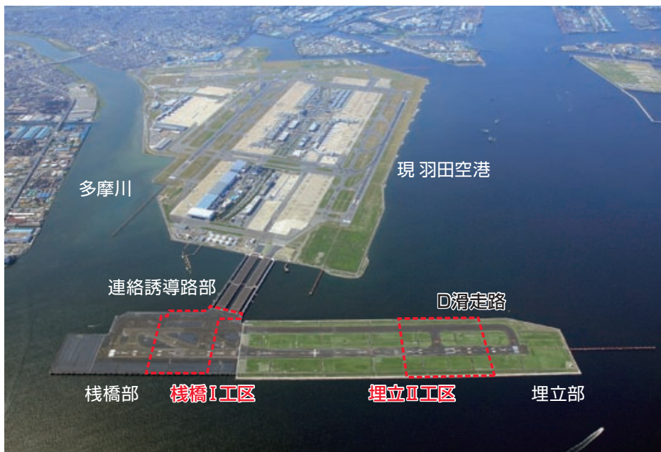
羽田空港とD滑走路全景。赤い枠内が当社が担当した工区。作業員や資機材の移動・運搬を海上輸送で行うため, 工事中は, 運航管理室による船の一元管理で海難事故防止が徹底された
