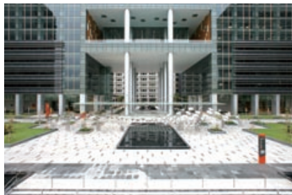
C棟とD棟の中間部に位置する“プラザ”2階の広場
