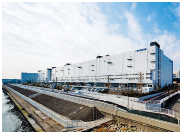
東京団地冷蔵株式会社再整備事業 (東京都) ■発注者 東京団地冷蔵株式会社
