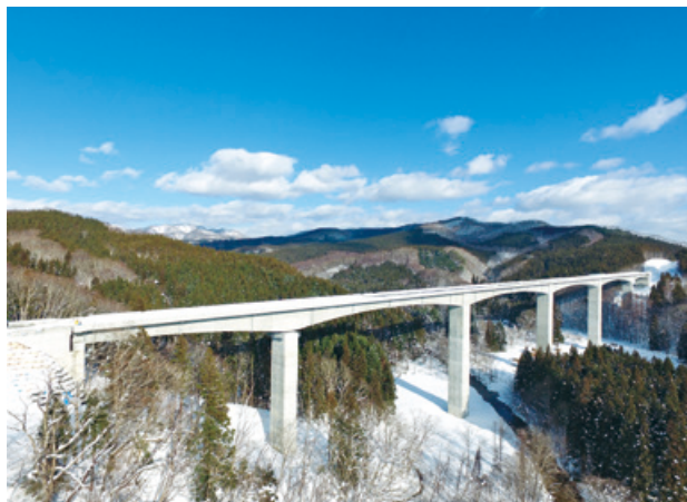
函館江差自動車道木古内町新亀川大橋上部工事 (北海道)
