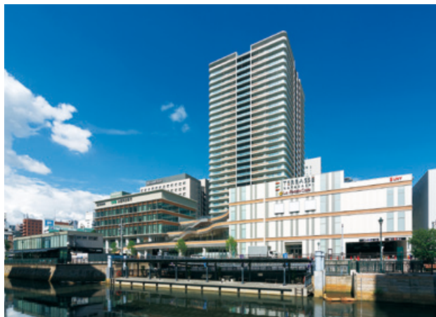
プラウドタワー名古屋・テラスセ納屋橋新築工事 (愛知県)
