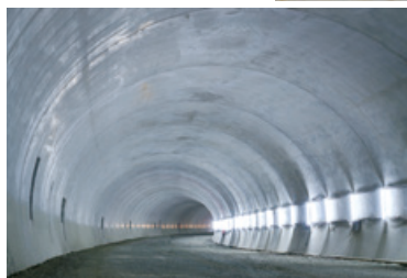
宮古盛岡横断道路 手代森トンネル工事 (岩手県)
