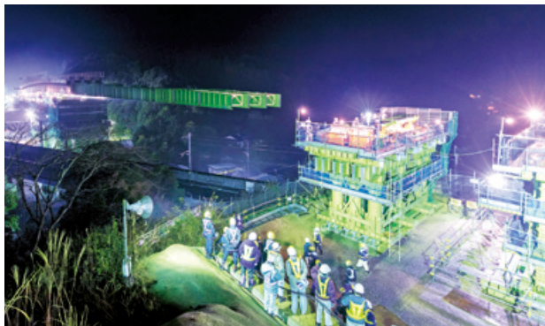
1月10日未明、小雨の中行われた手延べ機の送り出し作業
