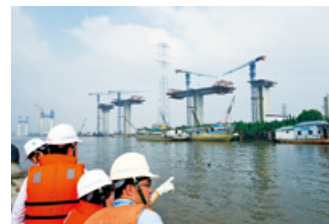
2017年度の見学会の様子 (ベトナム ビンカイン橋工事)
