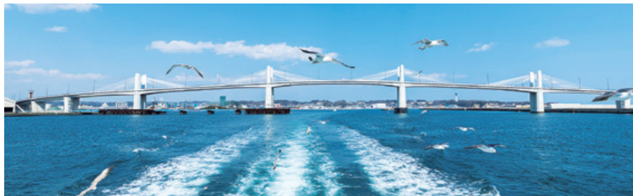
小名浜マリナブリッジの全景
