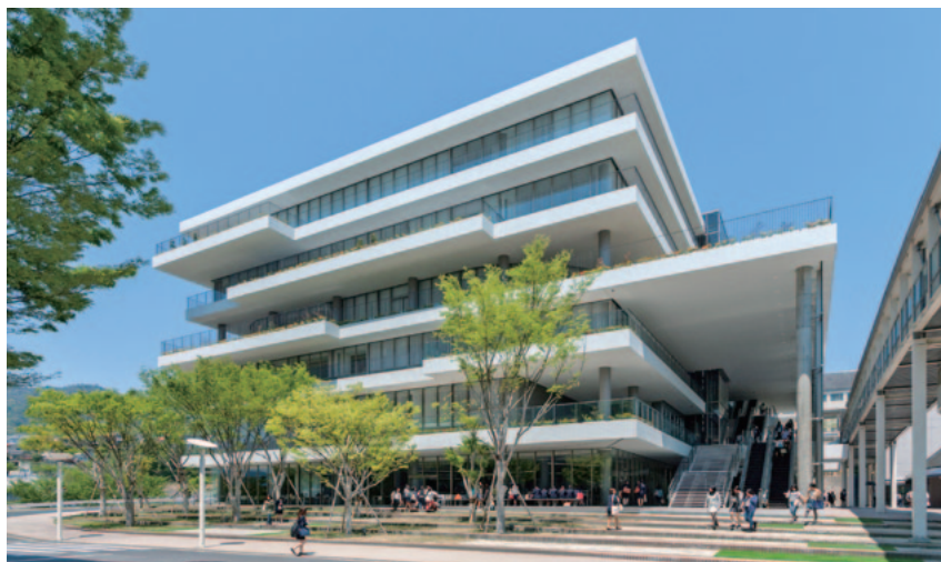
新5号館の全景
