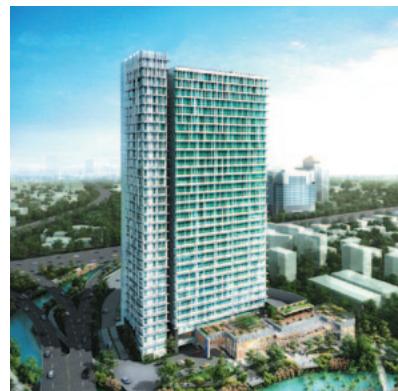
当社がインドネシア現地資本から受注した大型複合施設「シマトパン・ミックス・ユーズ・プロジェクト」
