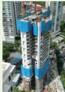
高層で躯体工事、 低層で仕上工事の 同時施工状況
