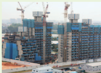
14階までの施工状況
