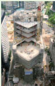
躯体工事の施工状況
