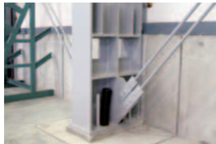
産業棟に設置した特別加工の鉄骨柱。 ジャッキアップ対応の開口を設けている
