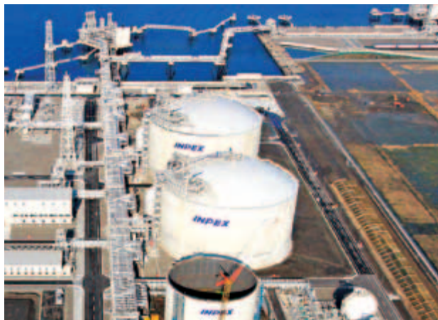
直江津 LNG 受入基地建設工事の内、タンク土木工事(新潟県)
