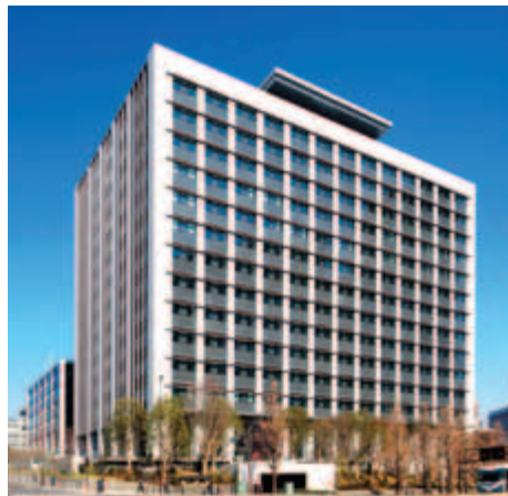
中央合同庁舎第8号館整備等事業 (東京都)
