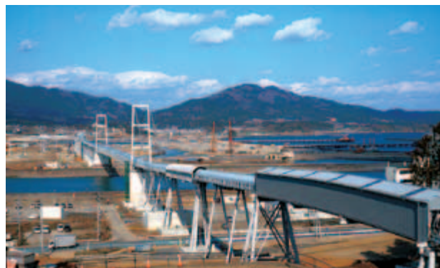
気仙川を横断する吊り橋と延長約3kmのベルトコンベア
