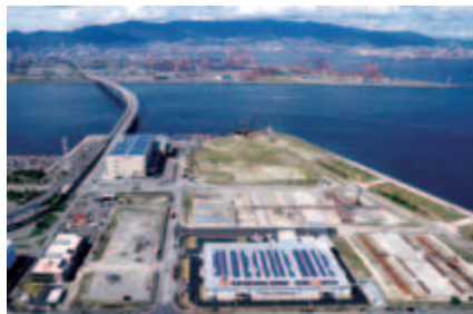
手前左が本社棟、空き地を挟んで右が産業棟。 対岸のポートアイランドの先に六甲の山並みが見える
