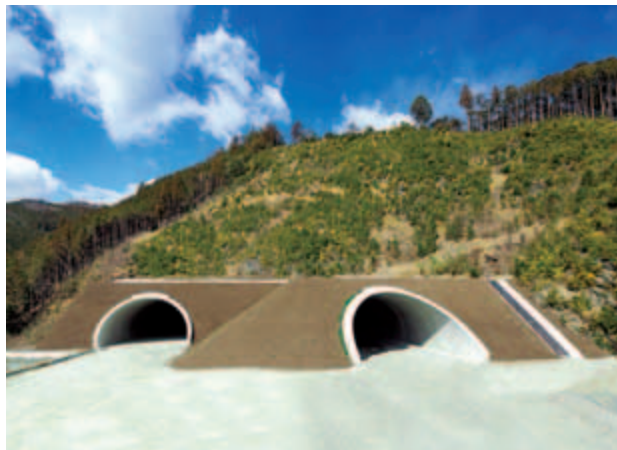
新東名高速道路 鳳来トンネル工事 (愛知県)
