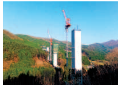
越喜来高架橋の橋りょう下部工施工の様子
