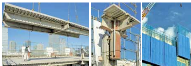
ビルのブロック化(写真、左2枚)とクレーンによる吊り下げ(写真右)
