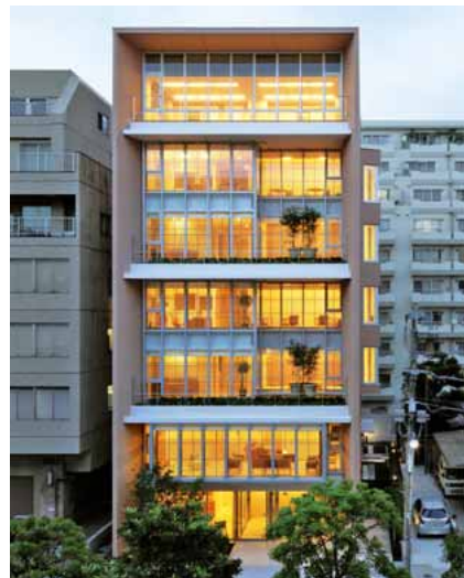
外観全景。3,4階、5,6階は2階建ての家を二つ重ねたようになっています
