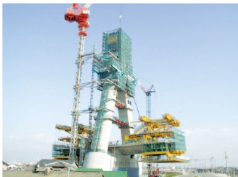
施工中の主塔
