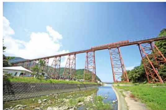
架け替え前の鉄橋。新橋の細身で直線的なデザインには旧橋のイメージが踏襲されています
