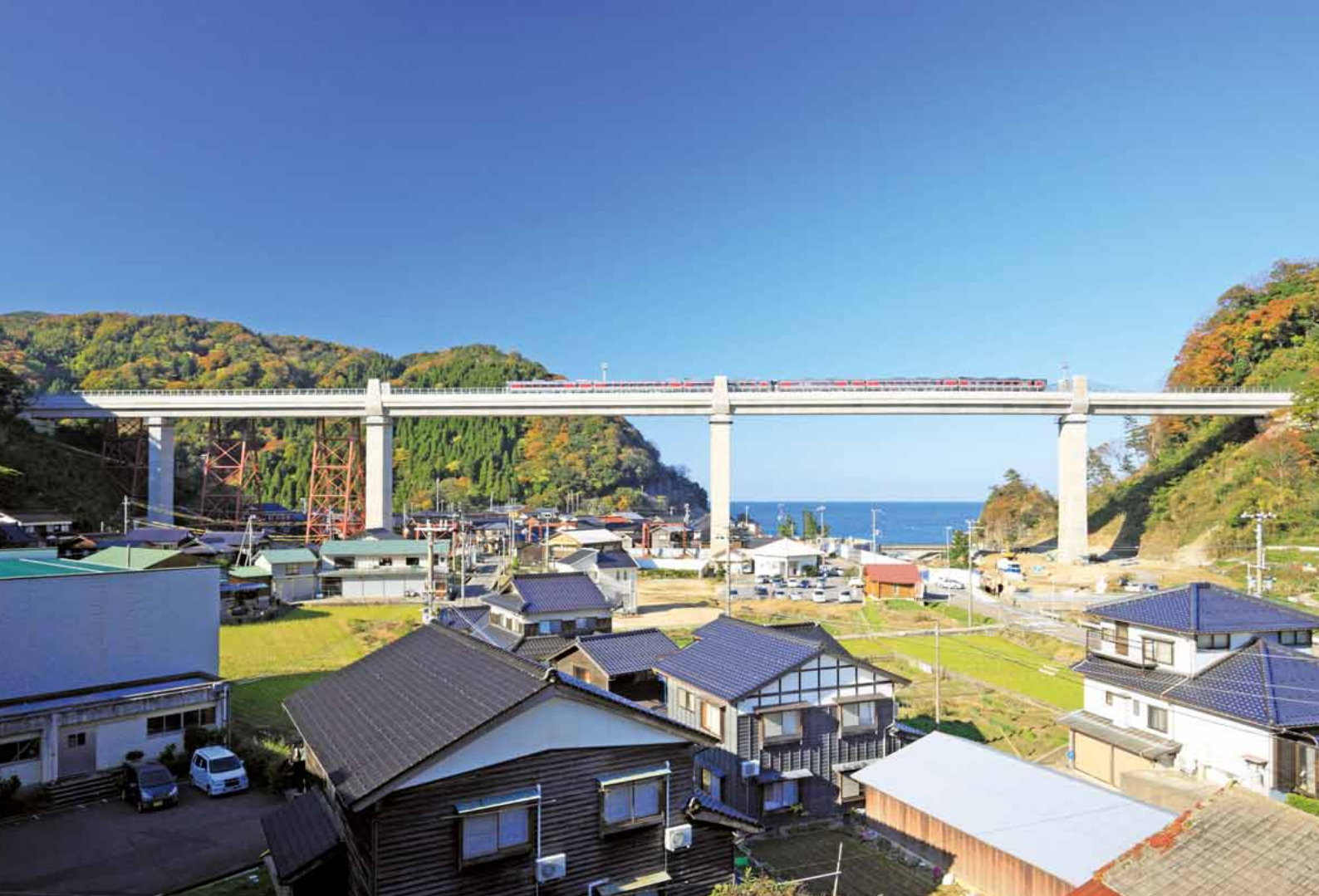
風速30mでも列車運行できるよう両側に厚さ15mmの防風壁が設置された新橋。アクリル板の採用で眺望も確保されました
