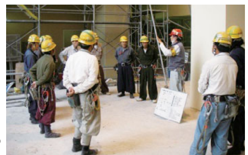
作業前の現地KY（危険予知のミーティング）
