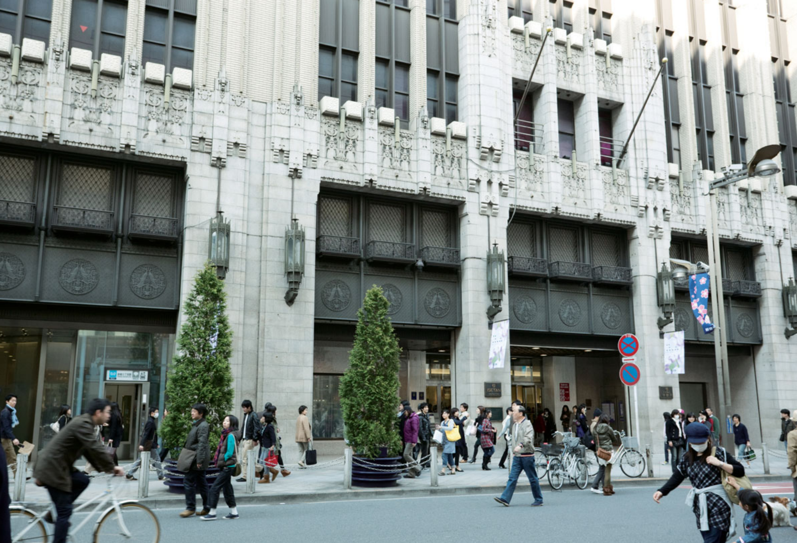
低層部の石の彫り込みやブロンズレリーフが、昭和8年の竣工時のまま保存されている新宿通り側エントランス
