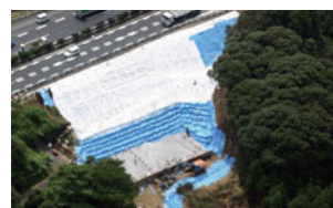
のり面保護シートによる防水処置と表面排水処理
