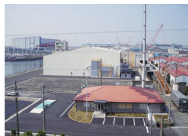
ダイオキシン類汚染土壌洗浄 プラント全景
