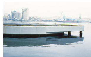
補修後の構造物
