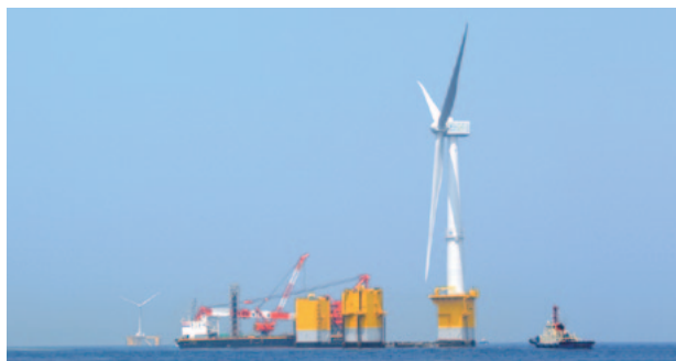
第2期工事「ふくしま新風」の曳航・係留作業。「ふくしま新風」は海面からの最高到達高さ189m、ブレードの長さ81.7m、浮体を含めた総重量7,200tで、規模、出力とも浮体式洋上風力発電施設としては世界最大
