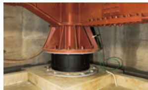
広野みらいオフィスに導入された免震装置と太陽光発電パネル
