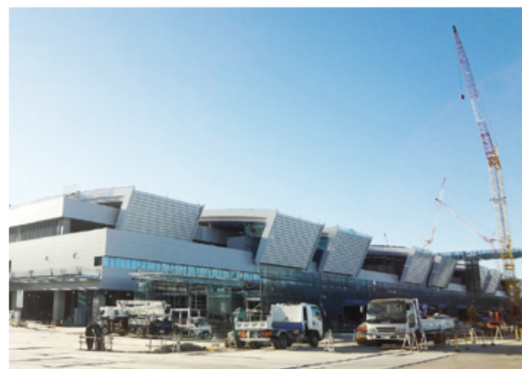
施工中の水産仲卸売場棟(2016年1月時点)
