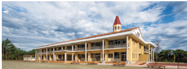
完成した南三陸町立戸倉小学校
