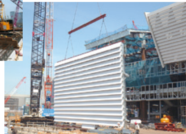
水産仲卸売場棟の地組みした 大型ルーバー
