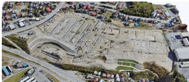
造成が完了した高田地区の高台
