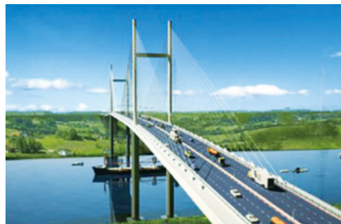
ベトナムの高速道路公社から受注した「ピンカイン橋」 (南北高速道路建設事業(ベンルック-ロンタイ間) J1工区建設工事)(全長2,764m, ホーチミン市)
