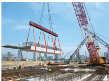
現場内に設けられたサイトPCヤード
