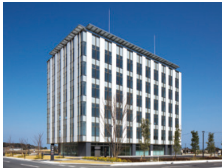
完成した 広野みらいオフィス
