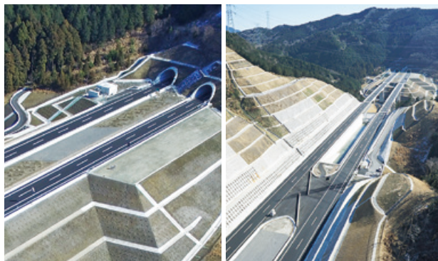
第二東名高速道路 観音山トンネル工事 (愛知県) ■発注者 中日本高速道路株式会社
