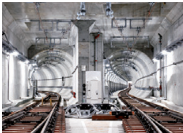
調布駅付近連続立体交差工事 (土木) 第4工区その3 (東京都)
