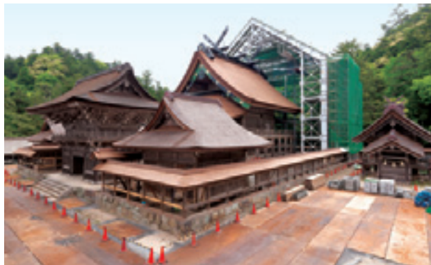
保存修理中の出雲大社本殿の様子
