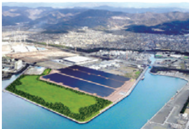
兵庫県赤穂市に開発中のメガソーラープラント完成予想CG (出力1万キロワット、平成26年度稼働予定)
