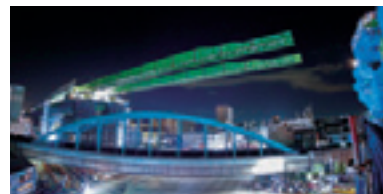
架設桁の送り出し作業中の 六番町新幹線跨線橋。 2013年11月竣工予定
