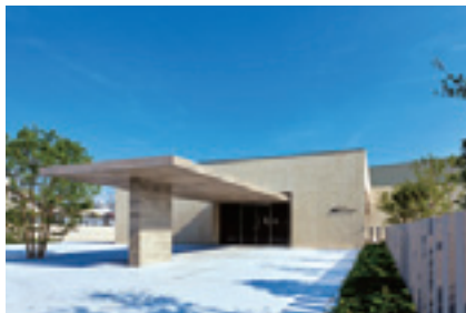
新館エントランス。本実型枠を用いた 打ち放しコンクリートの庇が目を引き
