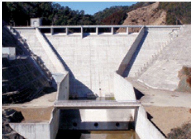
浜ノ瀬ダム第二期建設工事 (宮崎県)
