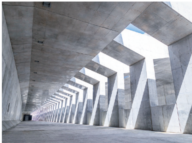
田尻地区函渠その6工事 (千葉県) ■発注者 国土交通省
