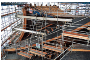
素屋根内、解体工事中の楼門
