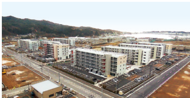
気仙沼市鹿折地区災害公営住宅 (宮城県) ■発注者 独立行政法人都市再生機構
