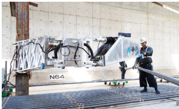
ロボット等を用いた生産性向上の一例 重量鉄筋の配筋作業を補助する「配筋アシストロボ」
