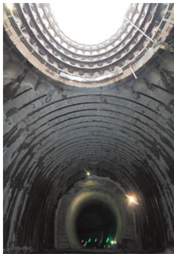
鹿野川ダムトンネル 洪水吐新設工事(愛媛県) ■発注者 国土交通省
