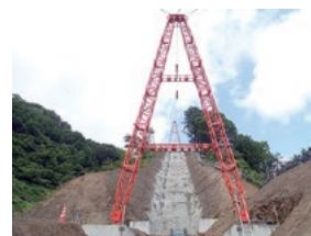
水圧管路の基礎工事
