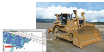
ICTブルドーザーによる敷き均し管理
