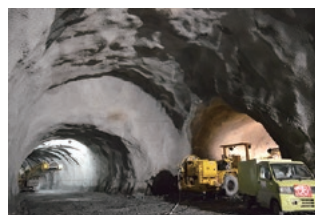
掘削中の導水路トンネル
