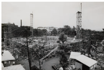
1958年、施工中の様子 写真提供：国立近現代建築資料館
