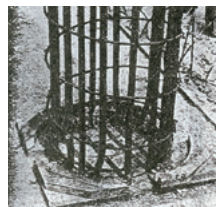
型枠建て込み前の円柱の足元 写真提供：文教施設協会
