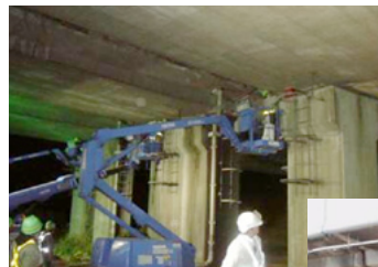
復旧作業の状況
