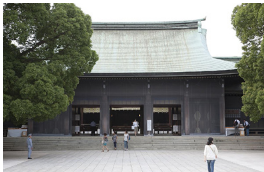
工事中の明治神宮外拝殿。仮囲いのシートに原寸大の外拝殿の写真をプリントしているため、一見ただけでは工事中には見えない
