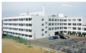
復旧作業完了後の校舎全景
