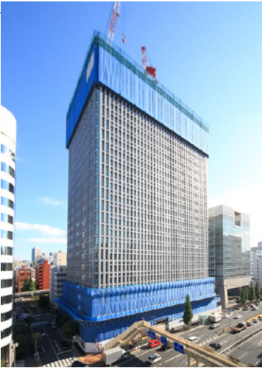
施工中の新本社
