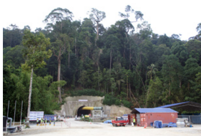
高さ50mにも達する巨木が密集する仮設トンネル1の坑口
