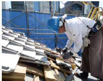
劇場屋根部分の瓦は職人が一つひとつ形状を調整・加工しながら設置
