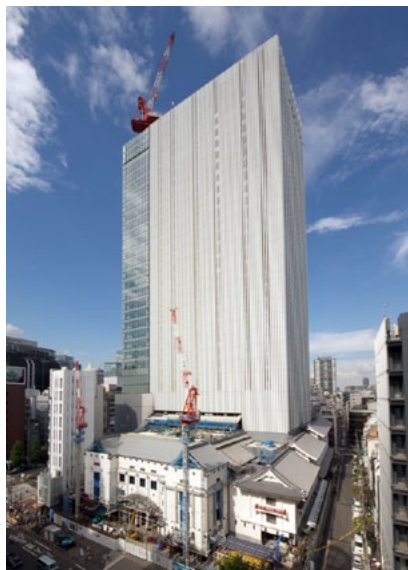
建て替え工事中の歌舞伎座の全景。オフィスビル部分はすでに上棟しており、地上29階、最高高さ145.5m
