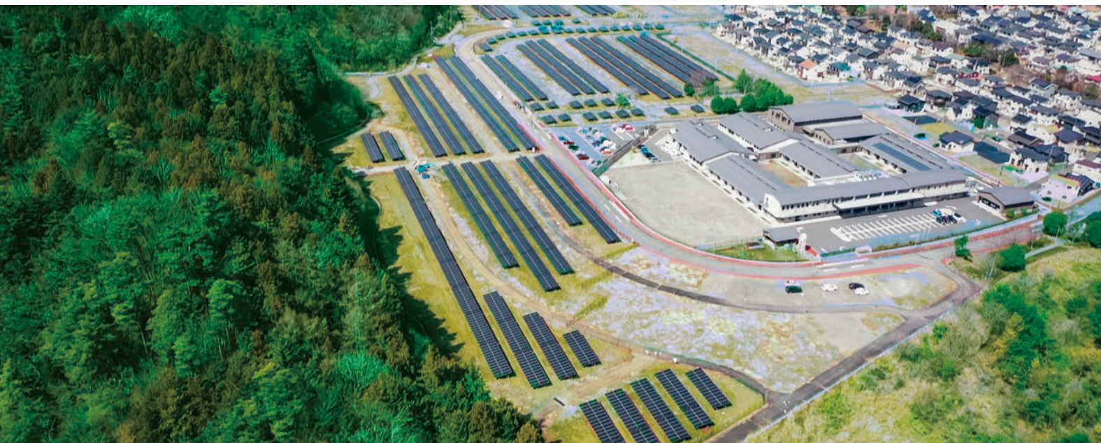
山梨大月太陽光発電所 (山梨県大月市)
