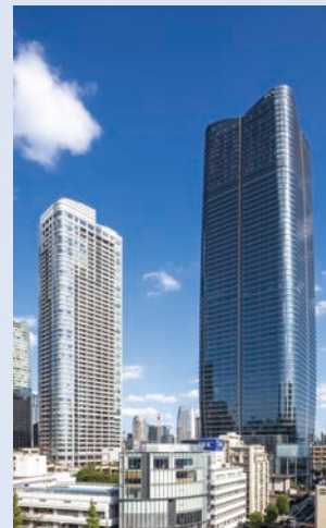
2023 左:麻布台ヒルズレジデンスA、右:麻布台ヒルズ森JPタワー 住宅・オフィス・文化施設・商業施設などの多様な都市機能と豊かな緑が調和した国内最大級の再開発プロジェクト
