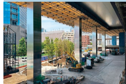
18mスパンの外周柱(1階の様子)
