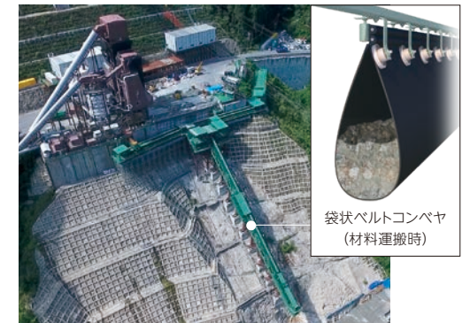
SCプレミアムベルコンの設置状況 (福井県今立郡池田町)
