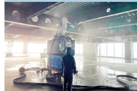
耐火被覆吹付ロボットによる実証施工
