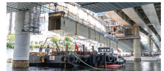
台船を活用した鋼製の橋桁の吊下げ降下撤去 (東京都中央区)
