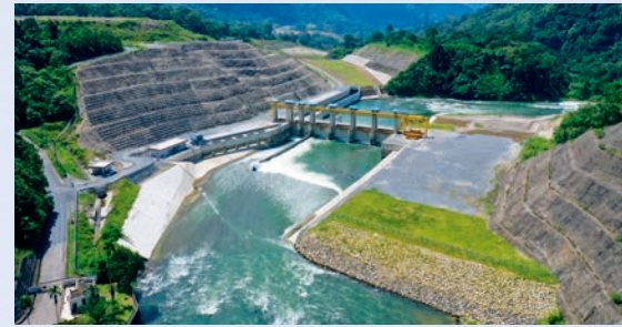
2024 アサハン第3水力発電所 (インドネシア) 全長10.9kmに及ぶトンネル、地下発電所、立坑などの多工種工事。BIMモデルなどのICTを積極的に活用
