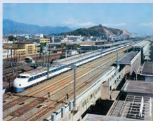
1964 東海道新幹線静岡駅高架橋 日本の東西をつなぐ国家的交通インフラ整備プロジェクトに参画
