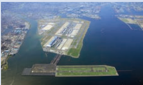
2010 東京国際空港D滑走路 世界でも珍しい埋立と栈橋のハイブリッド構造を採用した大規模海上滑走路 (画像提供:羽田再拡張D滑走路JV)
