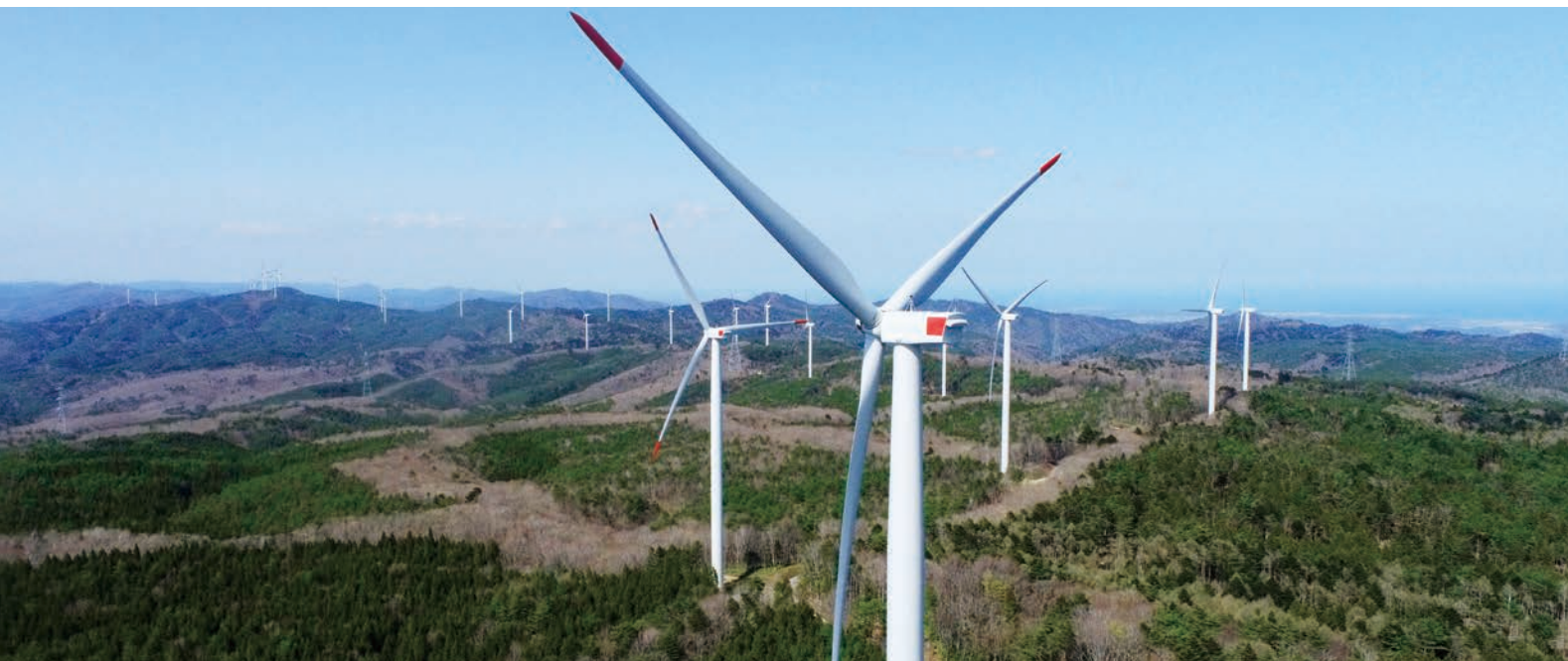
阿武隈風力発電所の風車建設（福島県田村市、大熊町、浪江町、葛尾村の4市町村にまたがる稜線部）
