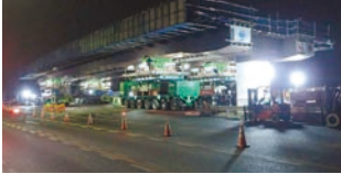
大槌橋西高架橋（国土交通省中国地方整備局発注） P1・P2間多軸台車一括架設状況
