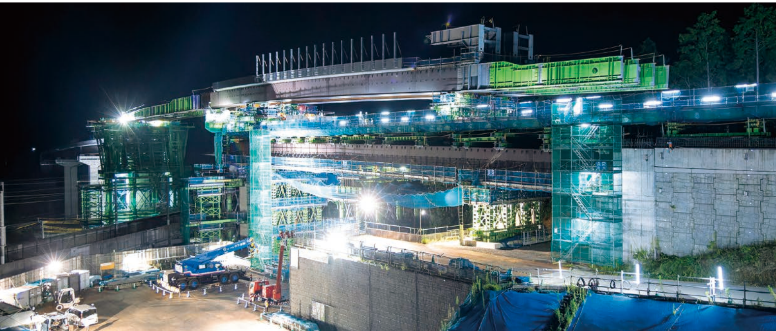
新水俣駅構内古城第2B○新設他3 (熊本県水俣市) 九州新幹線をまたぐ、手延べ式送出し工法による架設工事
