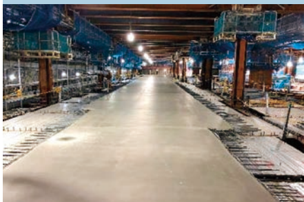
地下に資材運搬用の先行床を施工
