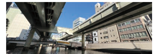
橋桁・橋脚撤去完了状況
