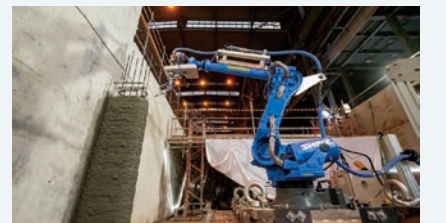
日本製鉄（株）瀬戸内製鉄所阪神地区（堺）における施工状況
