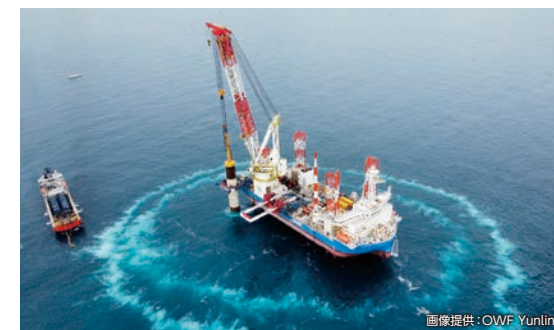
雲林沖洋上風力発電所建設工事（備船）のバブルカーテン（台湾） 画像提供：OWF Yunlin
