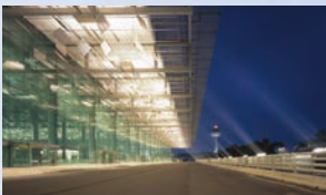
2007 チャンギ国際空港第3ターミナル (シンガポール) 東南アジアの重要な経済拠点のターミナル。幅300m×奥行215mの鉄骨トラスのリフトアップは世界初
