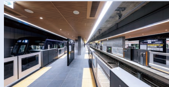
2024 相鉄・東急新横浜線、新横浜駅他 デジタルツールをフル活用し、生産性向上を図るとともに、施工管理の効率化・高度化を実現 ▶ P.38
