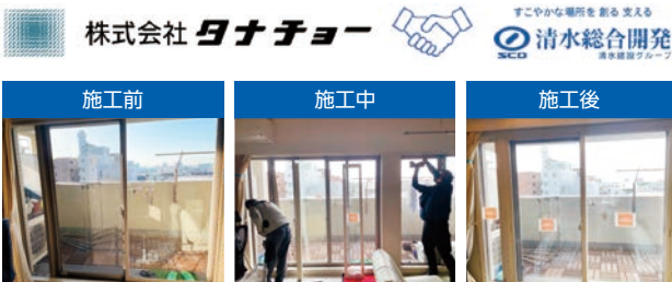
マンションの断熱性窓への改修工事
