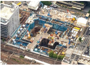
東京都「バイオ燃料活用における事業化促進支援事業」をTorch Tower建設現場にて実証中
