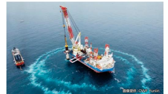
雲林沖洋上風力発電所建設工事(備船)のバブルカーテン(台湾)
