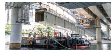
台船を活用した鋼製の橋桁の吊下げ降下撤去 (東京都中央区)
