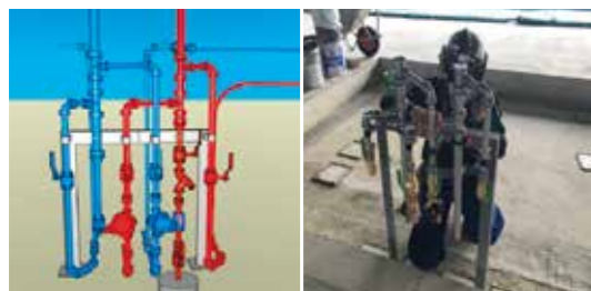
給水・給湯配管回りのユニット化例:図面(左)組立の様子(右)
