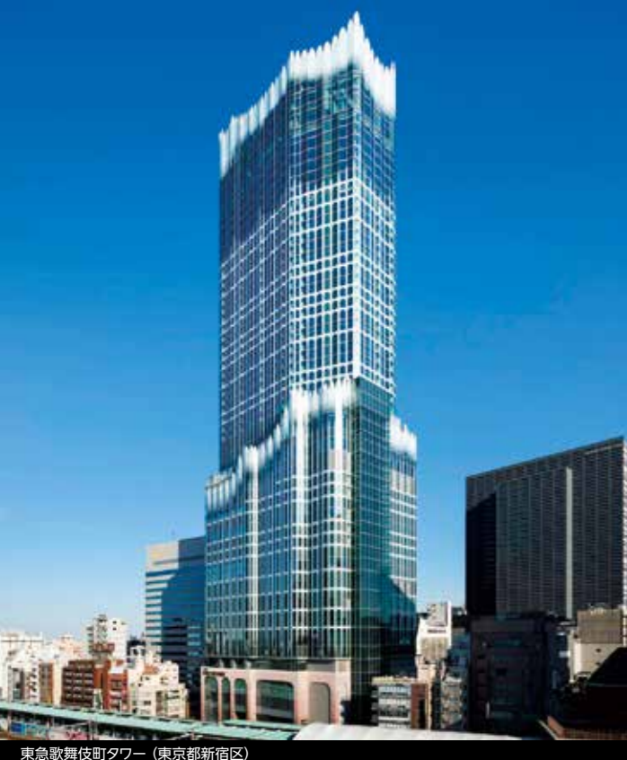
東急歌舞伎町タワー(東京都新宿区)
