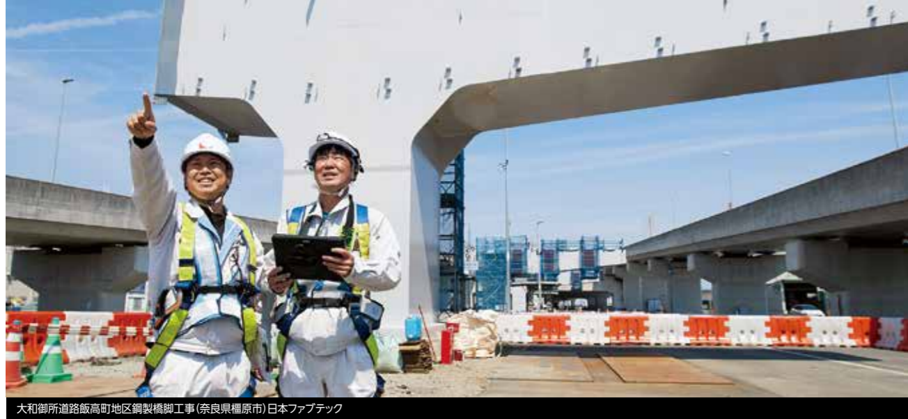
大和御所道路飯高町地区鋼製橋脚工事(奈良県橿原市)日本ファブテック
