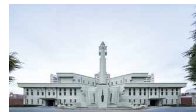
保存改修工事完了後の東京拘置所旧庁舎(旧小菅刑務所庁舎)の外観(東京都葛飾区)
