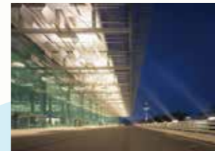
2007 チャンギ国際空港第3ターミナル (シンガポール) 幅300m×奥行215mの鉄骨 トラスのリフトアップは世界初
