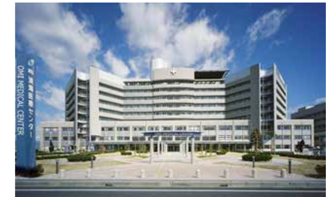
淡海医療センター 外観（滋賀県草津市）
