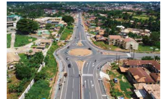
ガーナ第2の都市であるクマシを沿岸部につなぐ国道改修工事
