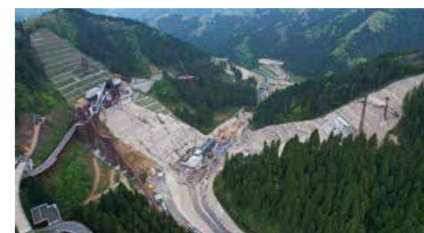
上流から望む足羽川ダムの施工状況(福井県今立郡池田町)
