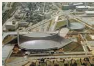
1964 国立屋内総合競技場主体育館 世界に類を見ないケーブルによる吊り屋根構造
