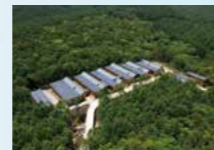
2013 生長の家 森の中のオフィス 省エネと創エネにより日本初の ZEBを実現
