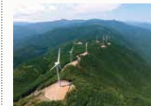
2020 ユーラス上勝神山ウインドファーム 2.3MWの風力発電機15基を 設置
