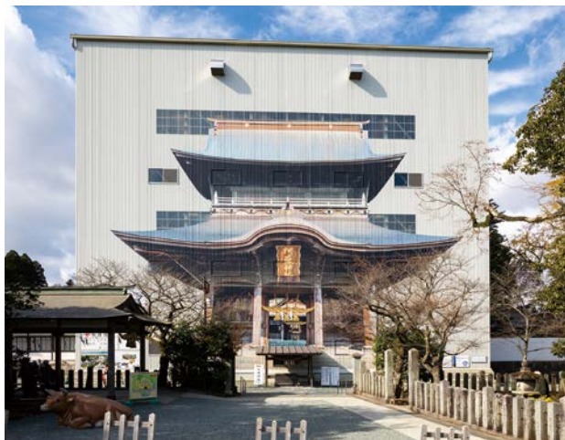
実物大の楼門が描かれた素屋根内部で工事を行った
