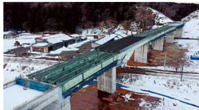
国道7号切石高架橋
