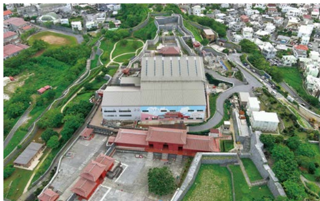
首里城全景。中央が正殿素屋根 提供：内閣府 沖縄総合事務局 国営沖縄記念公園事務所
