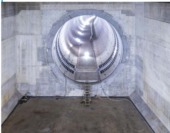
Aランプシールド(立坑入口)
