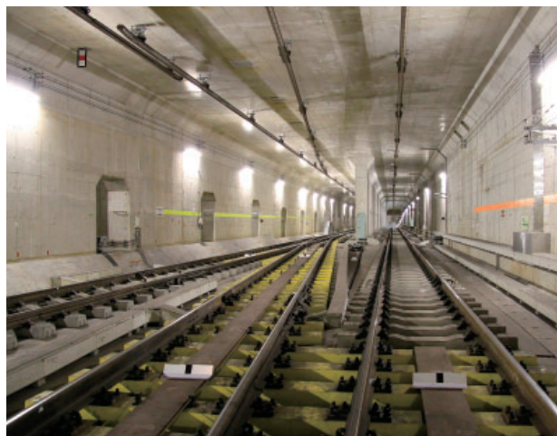
東京地下鉄13号線新宿三丁目一工区（東京都新宿区） 設計●東京地下鉄㈱
