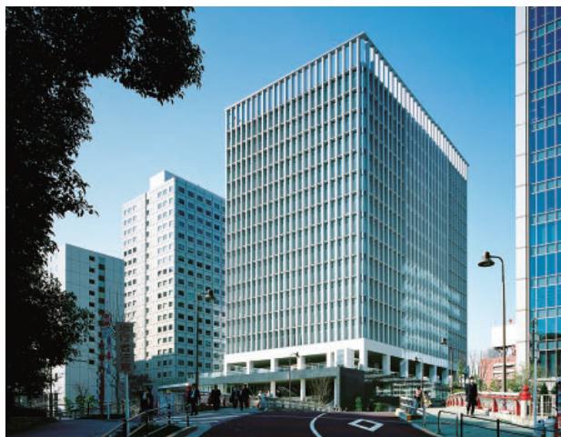
大崎センタービル（東京都品川区） 設計●当社
