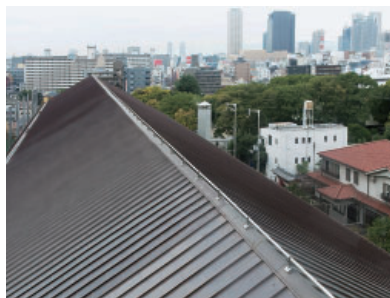
緻密な検証を重ね高品質を実現した、中学校舎の六寸勾配屋根
