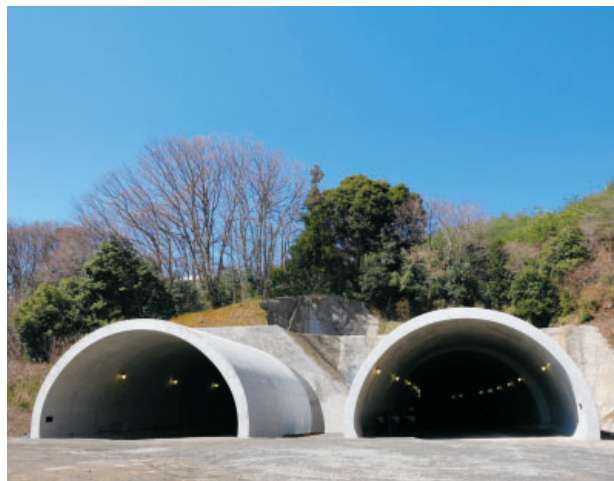
八王子南バイパス浅川トンネル（東京都八王子市） 設計●国土交通省
